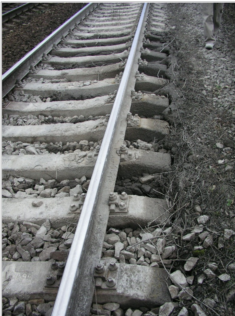
Foto 4: Pohled na znečištěné, zbahnělé kolejové lóže v traťové koleji č. 1 mezi žst. Zábřeh na Moravě - žst. Lukavice na Moravě
