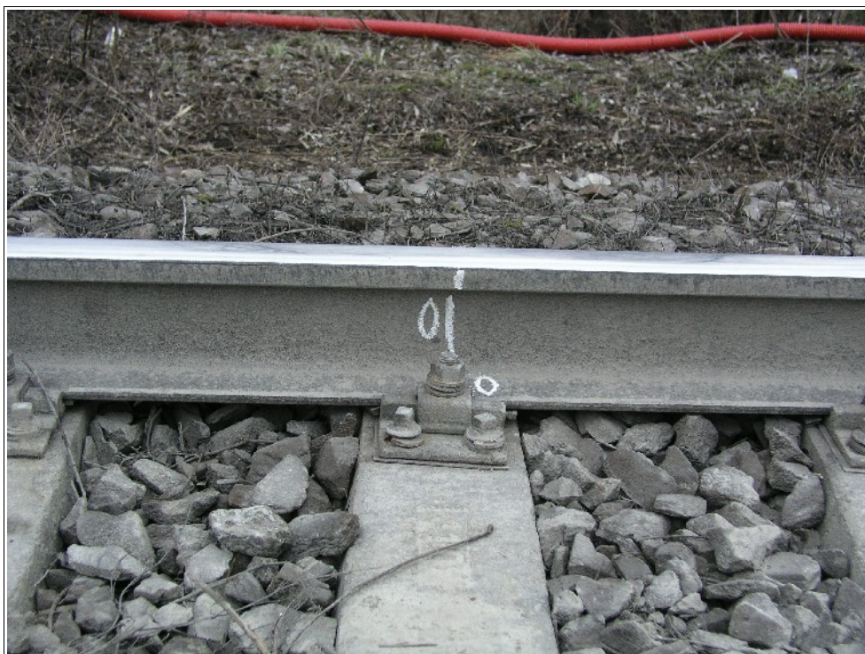
Foto 5: Pohled na místo první stopu po vykolejení na pravém kolejnicovém pásu
