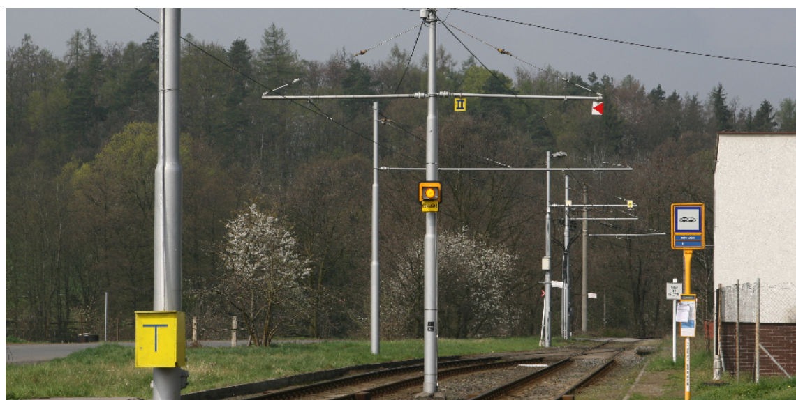
Foto 2: Výstražné světlo umístěné ve výhybně Dolní Lhota směrem k začátku trati (Budišovice, Zátíší). V popředí na snímku je zdokumentována žlutá uzamykatelná skříňka, v níž je umístěn telefonní přístroj služebního traťového telefonu.
