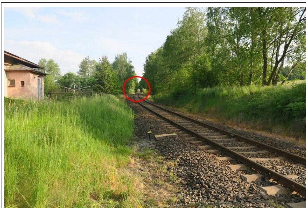
Obr. č. 13: Rozhled na trať vlevo a přijíždějící vlak (cca 230 m od ŽP) ve směru jízdy 2. OA k ŽP P3277 za stejných světelných podmínek Zdroj: PČR
