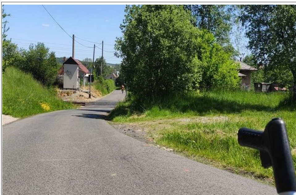
Obr. č. 3: Viditelnost výstražníku ve směru jízdy od Dymníku nebyla zajištěna na požadovaných 40m Zdroj: DI
