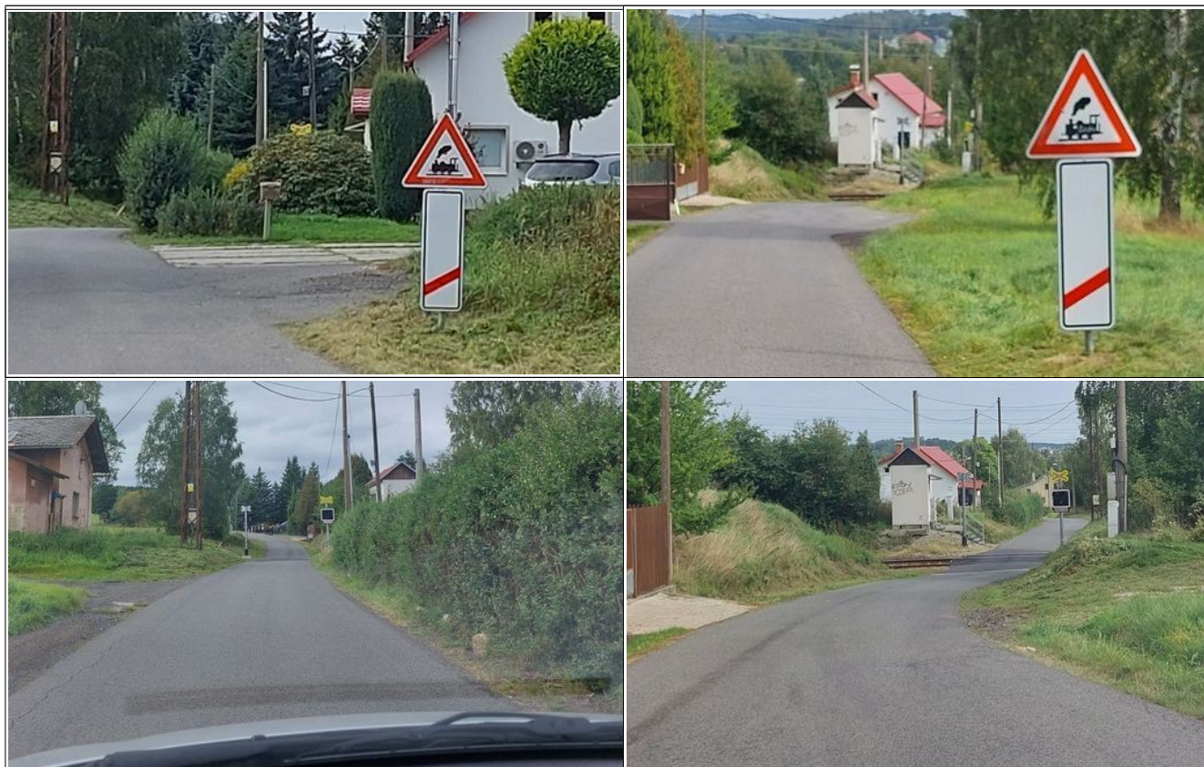
Obr. č. 22: Fotodokumentace dopravního značení a rozhledových délek Dz před ŽP P3277 ze dne 25. 9. 2023 Zdroj: Městský úřad Rumburk
