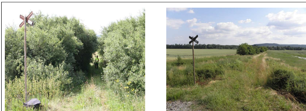
Ukázka důsledku zásahu Dražní inspekce: vlevo je přejezd v Bakově nad Jizerou – řidič jedoucí k němu vůbec nevidí vlevo ani vpravo na koleje; vpravo je tentýž přejezd po té, co Dražní inspekce vyzvala provozovatele dráhy ke zjednání nápravy. Podle Ministerstva dopravy neměla Dražní inspekce tyto kontroly provádět; agendu měl převzít Dražní úřad, který ji však v praxi téměř neprovádí.
