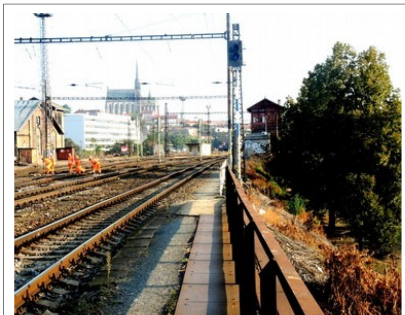
Obr. č. 5: Návěstidlo Se45
