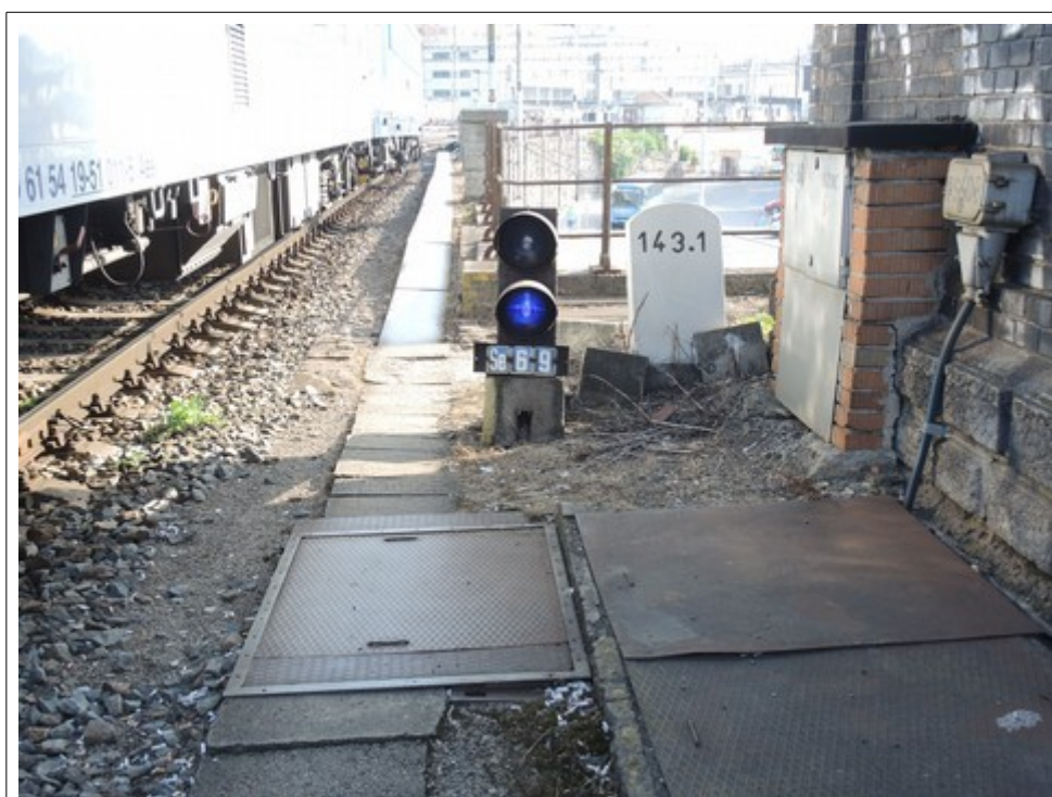
Obr. č. 11: Detail návěstidla Se69
