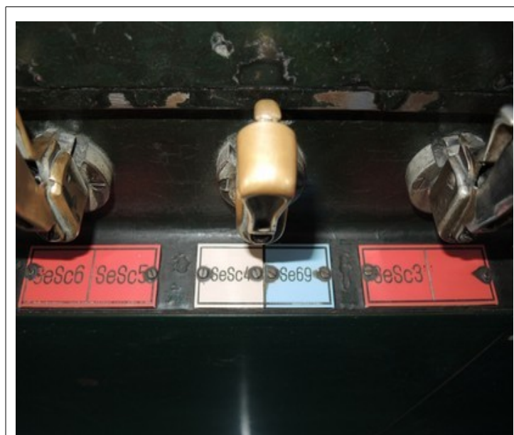
Obr. č. 9: Návěstní klička SeSc4/Se69 Zdroj: Dráží inspekce
