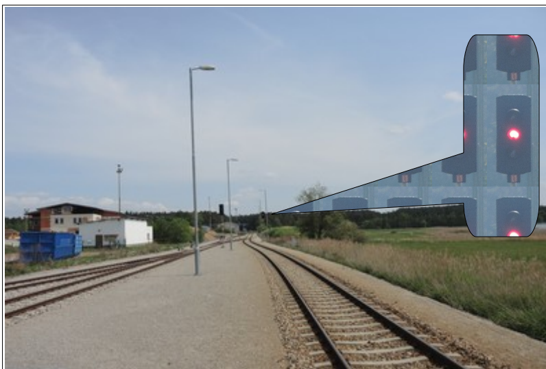
Obr. č. 7: Viditelnost odjezdového návěstidla L1 s návěstí „Stůj“ ze vzdálenosti 100 m Zdroj: DI
