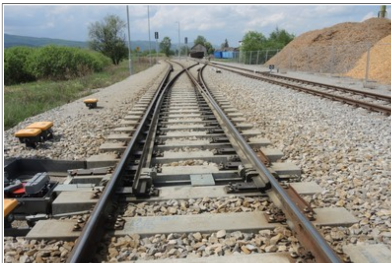
Obr. č. 5: Výchybka č. 6 násilně přestavená pro jízdu z 1. SK žst. Křemže do přímého směru
